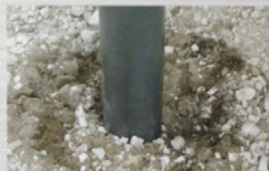
回転貫入状況
