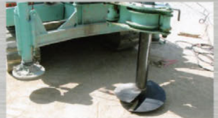
軸翼径比4.5倍の杭
